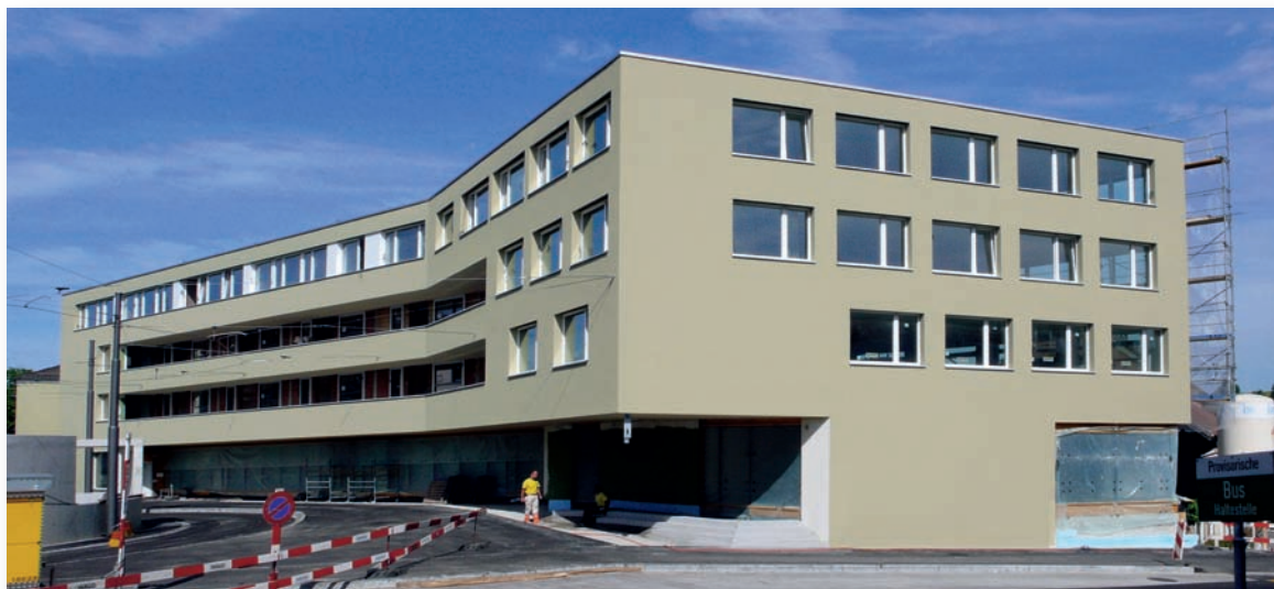
Das Neubauprojekt der Basellandschaftlichen Gebäudeversicherung am Kronenplatz – 14.09.2008
